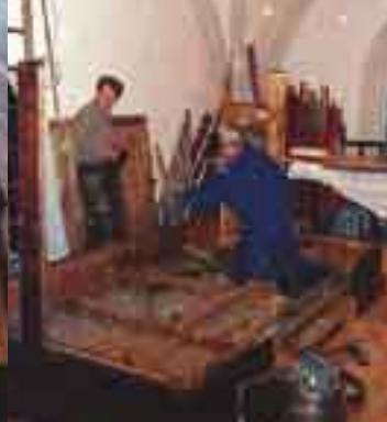
...bis auf das Fundament
